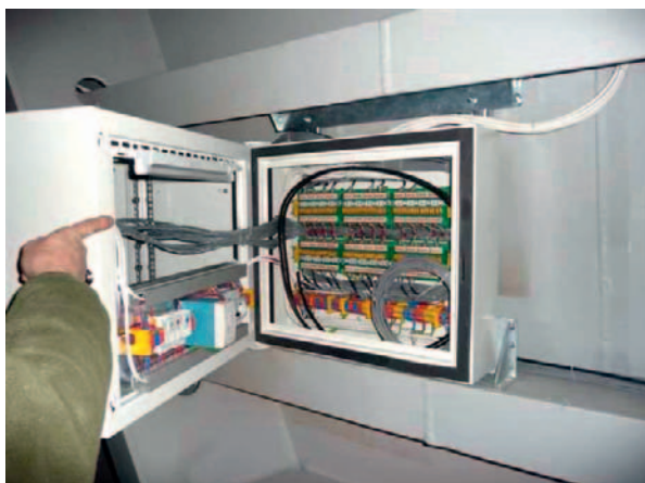
Fot. 1. Widok wnętrza serwera lokalnego zlokalizowanego na moście
